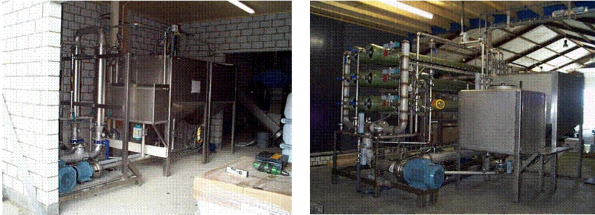
**Abbildung 11:** Links: Ultrafiltrationsanlage auf einem Mastschweinebetrieb. Vorne links die Förderpumpe mit den Membranmodulen, anschliessend Reinigungs- und Arbeitsbehälter. Rechts: Umkehrosmoseanlage auf einem Mastschweinebetrieb. Im Hintergrund links sind die Membranmodule zu sehen.
