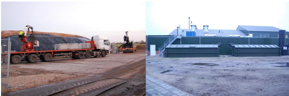
**Abbildung 52:** Überbetriebliche, zentrale Vergärung von Schweinegülle mit NAWARO (Maissilage) und Aufbereitung der Gärreste mit der Membrantrennung in Holland. Rund 70 Landwirtschaftsbetriebe sind an der Anlage beteiligt und liefern ihre Gülle zur Anlage. Im Bild ist links ein Fahrsilo für den Mais und rechts die Fermenter zu sehen.
